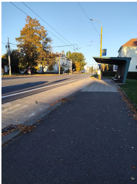
Foto 1 Celkový pohled na zastávku a zastávkový záliv ve směru do centra.
